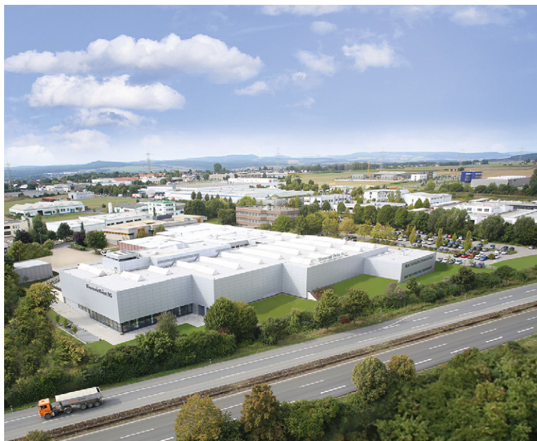
Vue aérienne de l'usine de Limburg-Lahn.
