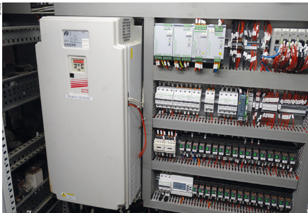
Variateurs du réseau de bord.
