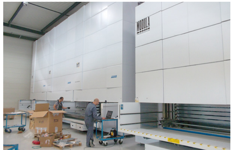
Bondioli & Pavesi France a investi dans la mise en place de quatre magasins verticaux automatiques qui viennent s'ajouter à plus de 3 km de rayonnages.
