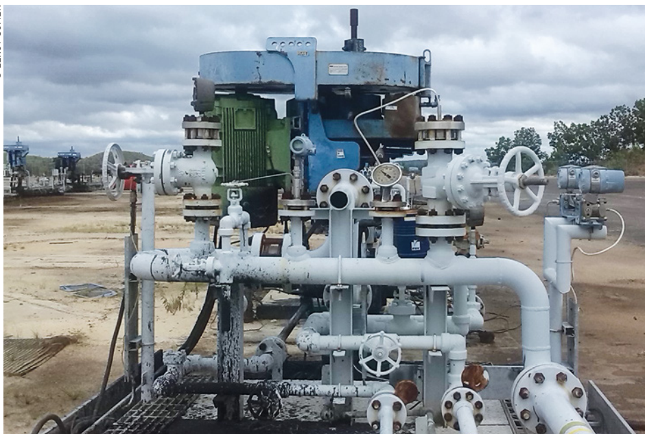
Les variateurs et moteurs de Leroy-Somer sont installés au sein des pompes pour équipements pour l'extraction artificielle (plus photo ci-dessous)
