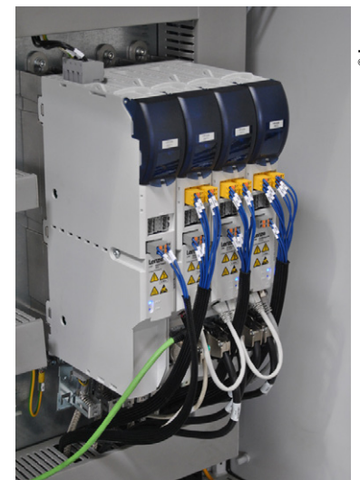
Servovariateurs i700 multi-axes avec module alimentation en tête commandés via bus EtherCAT.
