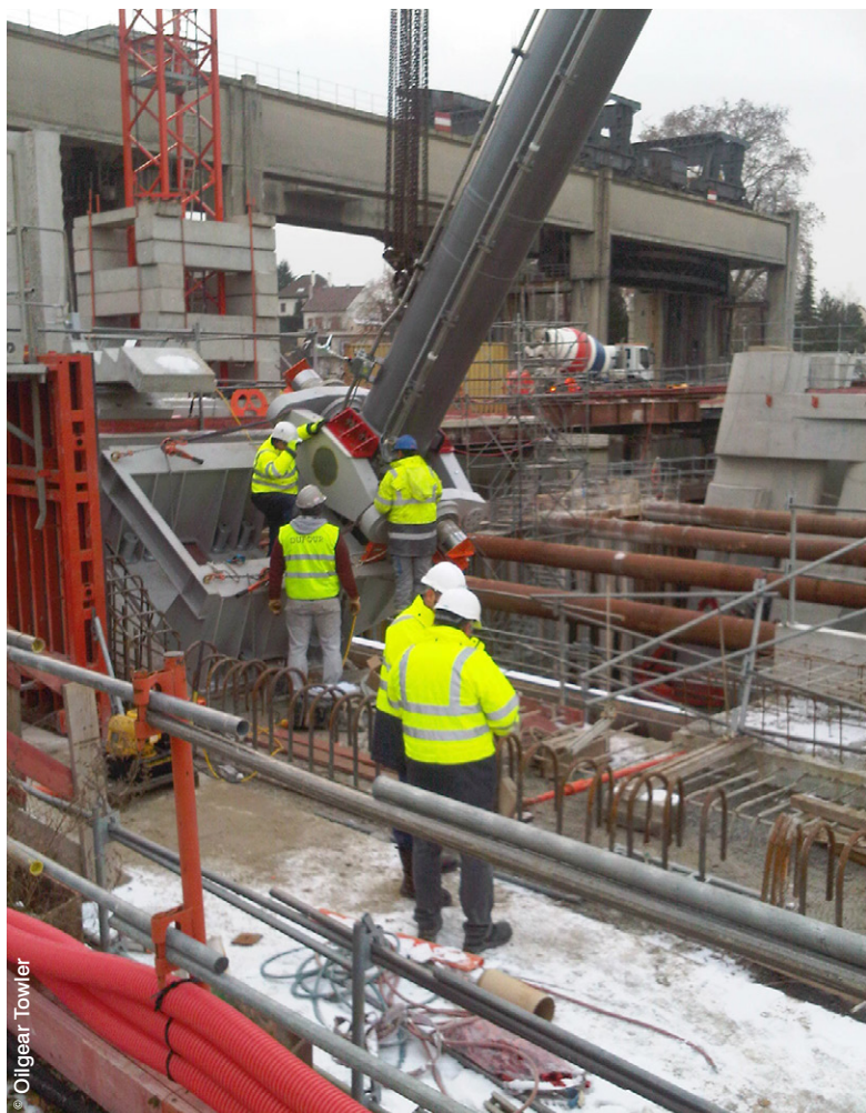
La filiale française du groupe joue un rôle de premier plan dans le domaine de la motorisation hydraulique et de l'automatisation des grandes infrastructures telles que les ponts, les barrages, les écluses et autres équipements sportifs.
