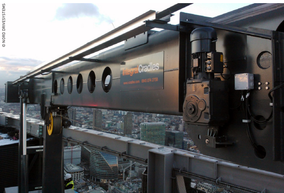
Un motoréducteur Nord SK 9072.1 entraîne la flèche télescopique de la BMU installée sur le Leadenhall Building.
