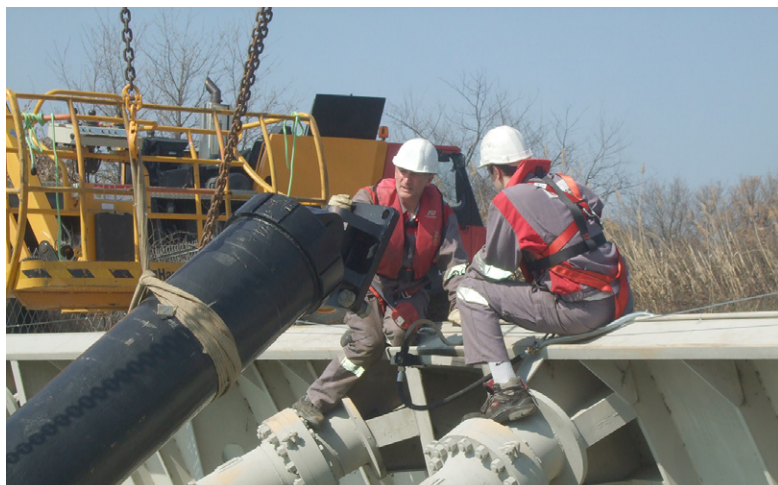
Réparation de vérins hydrauliques sur site.
