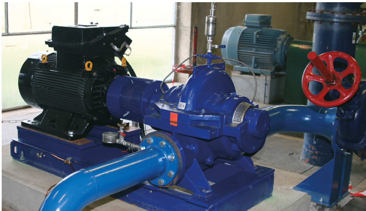
Groupe motopompe avec moteur Nidec Leroy Somer LSHRM 110KW IE5_1
