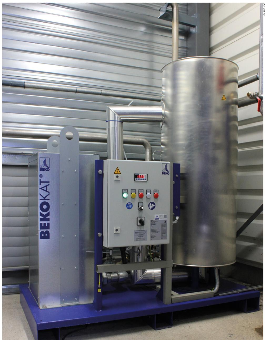
Le système de catalyse BEKOKAT a permis d'obtenir un air comprimé exempt d'huile, de germes et de bactéries ce, même en utilisant un compresseur lubrifié (obtention d'un air comprimé à 3/1000<sup>ème</sup> de milligramme d'hydrocarbures par m<sup>3</sup>, soit un résultat bien meilleur que la classe 1 qui va de 0 à 1/100<sup>ème</sup> de milligramme).
