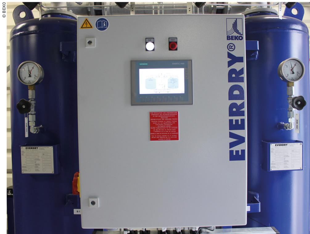
Le sécheur adsorption EVERDRY FRA-VPlus, fait partie – avec le convertisseur catalytique BEKOKAT – des éléments constitutifs du cœur de la nouvelle alimentation en air comprimé de l'entreprise La Salaison Polette.
