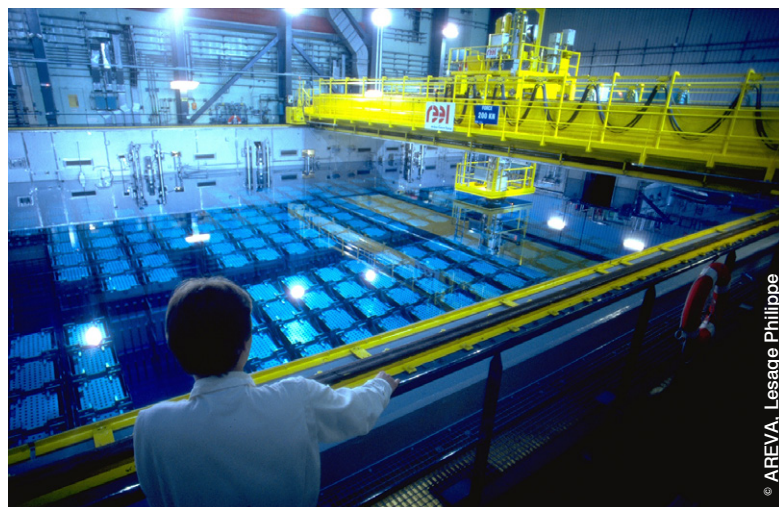
© AREVA, Lesage Philippe Piscine d'entreposage des combustibles usés. Usine de traitement des combustibles usés AREVA, établissement de La Hague. Cherbourg. France
