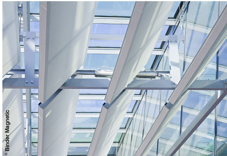
Ces façades de bâtiments sont équipées de systèmes « brise-soleil » pilotés par des vérins IP67 en inox fournis par Binder Magnetic et dotés de capteurs leur permettant de s'adapter aux conditions météorologiques.
