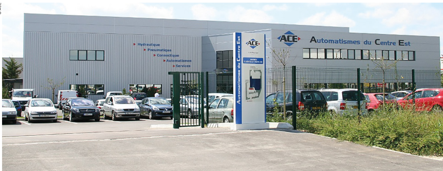
Le site d'ACE à Dijon est sorti de terre en 6 mois à peine.
