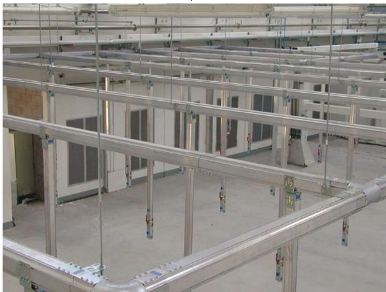
Alimentation de l'unité de fabrication de navires de plaisance Cranchi
