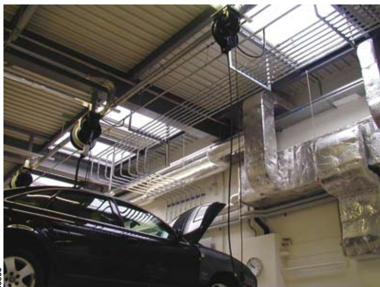
Huit lignes parallèles pour la distribution d'air comprimé, de liquides réfrigérants et d'huiles moteurs chez Amag, concessionnaire Audi en Suisse.
