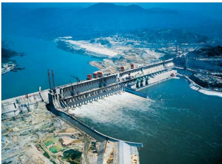
Barrage des Trois-Gorges. Les joints Simrit sont utilisés au niveau des fermetures/ouvertures des vannes et pour les directrices des turbines.
