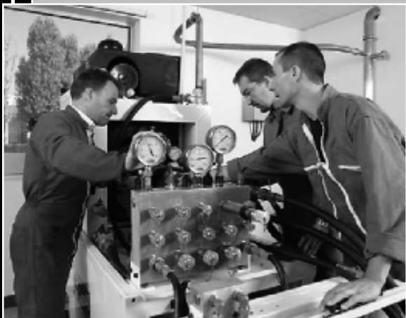
Vue générale du groupe de génération
