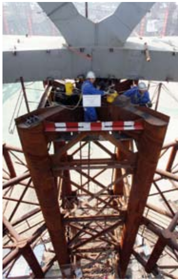
78 supports temporaires ont été nécessaires pendant la construction du toit.
