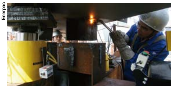
Découpe des joints de soudure des supports temporaires
