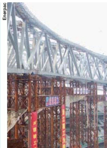
Un système hydraulique Enerpac a été monté sur chacun des 30 supports du cercle central
