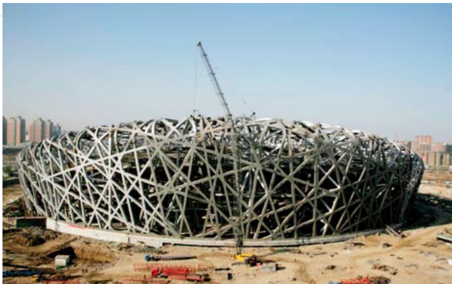
Entretroisements des 45.000 tonnes de pièces en acier
