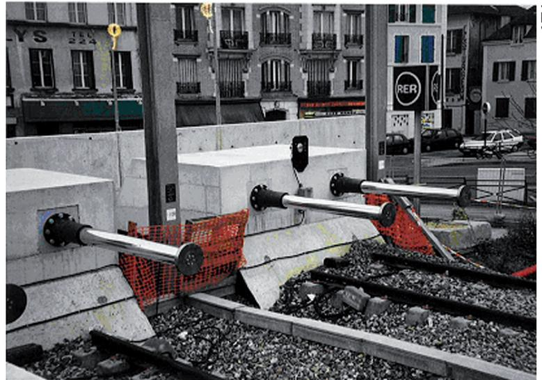
Cet amortisseur à absorption de grosses énergie arrête un train de 480 t à 10 km/h sur les 2 mètres de course de l'amortisseur. Ce dispositif est réutilisable immédiatement sans aucune intervention.
