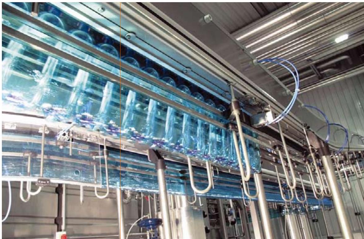
Le compresseur ZD peut alimenter simultanément deux réseaux : le réseau d'air haute pression pour le soufflage et le réseau d'air moyenne pression pour l'étiquetage, l'instrumentation et le capsulage
