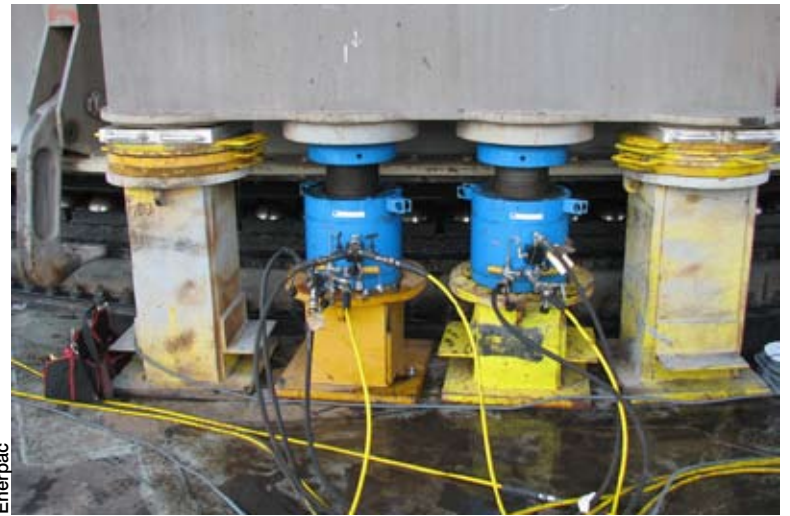
Levage et descente synchronisés de la drague de 5000 tonnes au moyen de six cylindres hydrauliques de 630 tonnes utilisés deux par deux aux trois points de levage.
