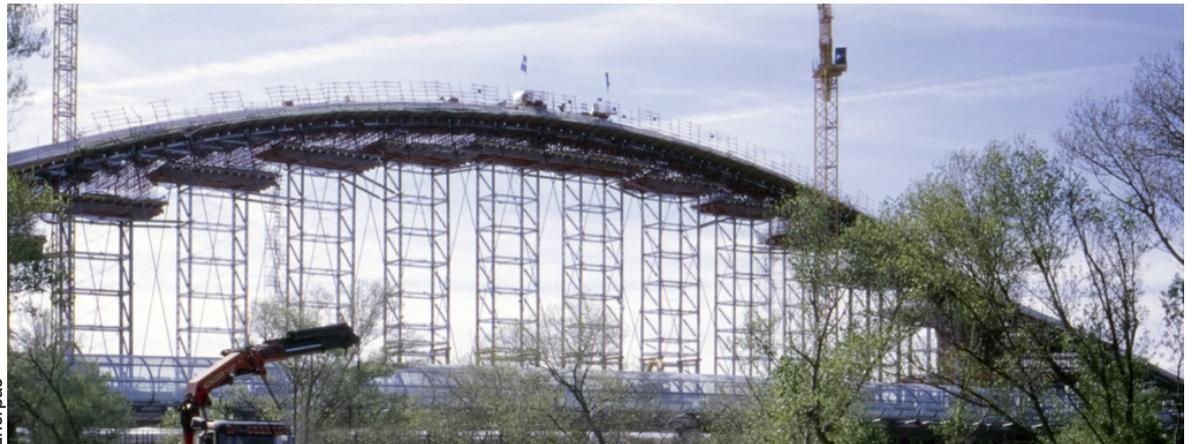
Une procédure délicate de levage hydraulique modèle le pont en arc bow-string du troisième millénaire à Saragosse.
