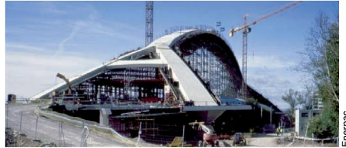
Les systèmes hydrauliques de levage synchronisé Enerpac ont déplacé l'arc en béton et écarté les poutres cantilever créant de l'espace pour le moulage définitif du pont du troisième millénaire à Saragosse (Espagne).
