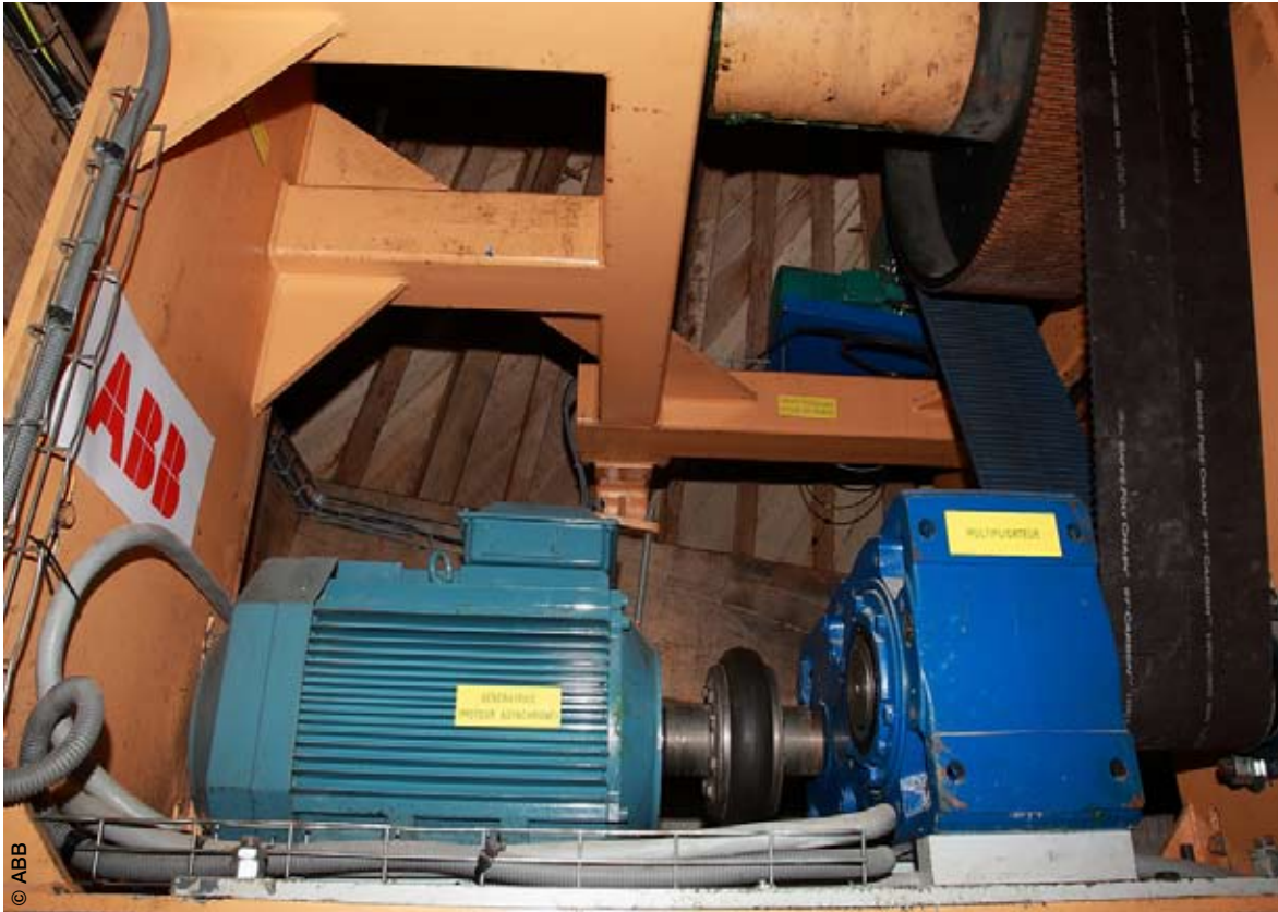
Sous la toiture, dans la tourelle mobile, se trouve la machinerie : le multiplicateur (bleu foncé), entraînant la génératrice ABB (bleu claire) via une liaison souple autorisant de légers défauts angulaires ou d'alignement.
