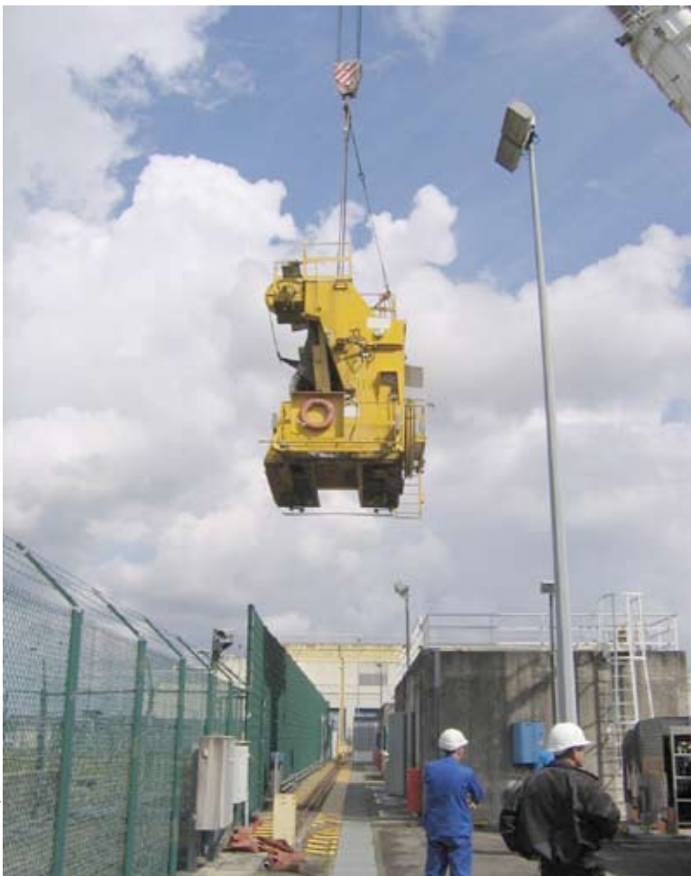
Fluidexpert a procédé à la réfection d'un dégrilleur sur barrage, faisant intervenir ses compétences en automatismes, mécanique et peinture, en plus de son cœur de métier, l'hydraulique.
