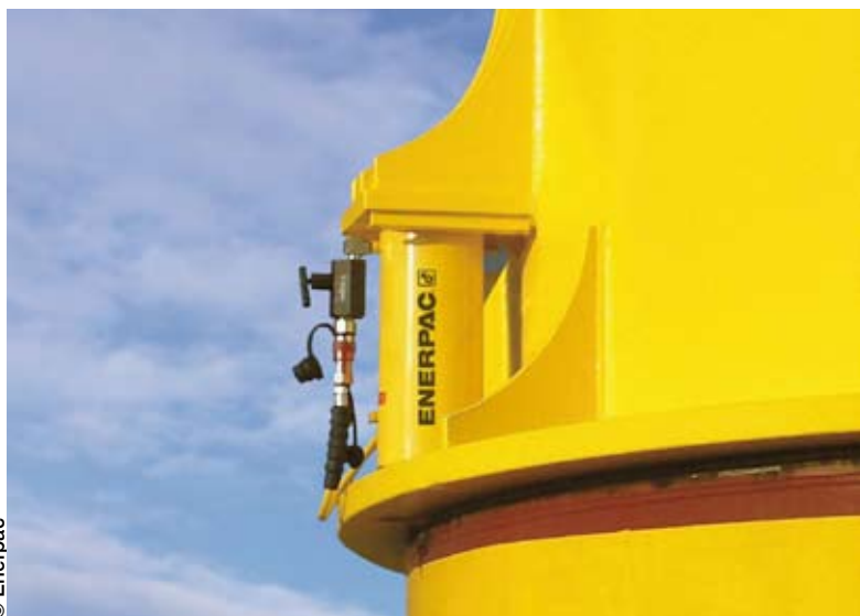
Lors de l'installation de la croix d'appui, trois vérins ayant chacun une capacité de 100 tonnes sont répartis et montés autour de chaque pilier.
