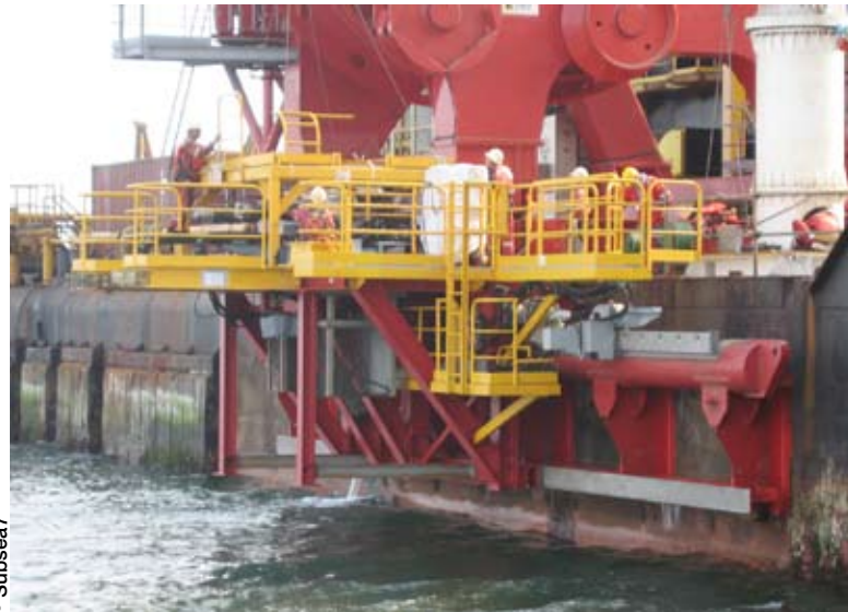
« Étude et réalisation de systèmes hydrauliques et électriques pour le SHOP (Sliding Hang Off Platform). Mise en place, essais et mise en route sur FPSO Polaris (Floating Production Storage and Offloading). »
