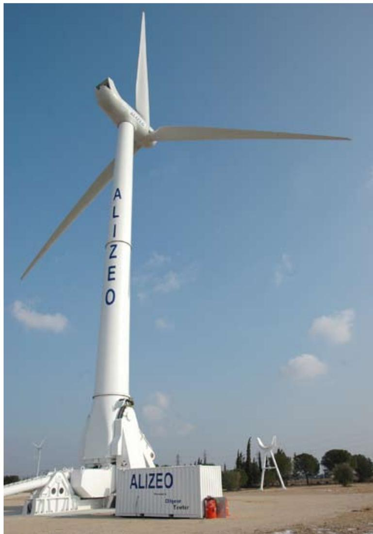
**Oilgear Towler est impliqué dans le développement durable, notamment au niveau d'applications telles qu'un prototype d'éoliennes de fortes puissances rabattables hydrauliquement, destinées à être installées dans des zones soumises aux cyclones.**
