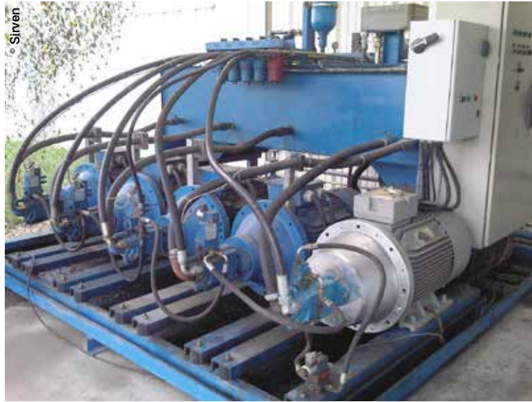
Centrale de generation 300KW pour banc de test essais mécanique Instron.
