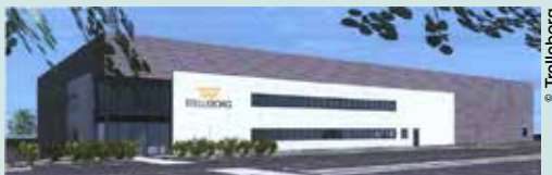
La nouvelle usine sera mise en service fin 2014.
