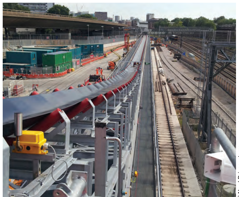
Chaque heure, plusieurs milliers de tonnes de matériaux creusés doivent être évacués.
