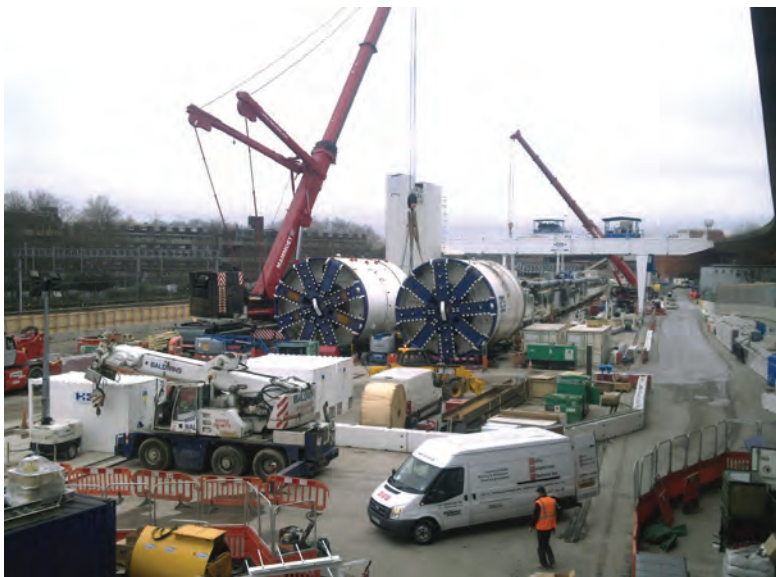
Les tunneliers du projet London Crossrail ont été fournis par la société allemande Herrenknecht.
