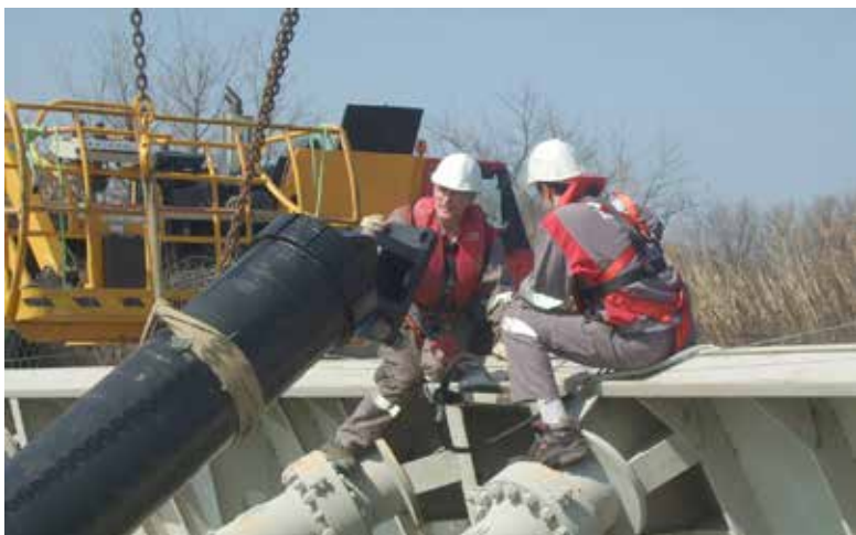
Réparation de vérins hydrauliques sur site.
