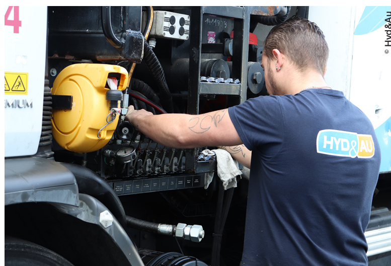
Le service Réparation du groupe Hyd&Au procède à des diagnostics et des remises en état des équipements avec des pièces d'origine constructeurs.
