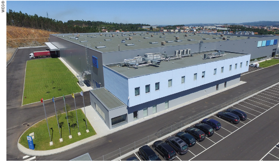
L'usine de moteurs électriques basse tension à Santo Tirso, au Portugal, devient le plus grand site de fabrication de moteurs électriques WEG en Europe.
