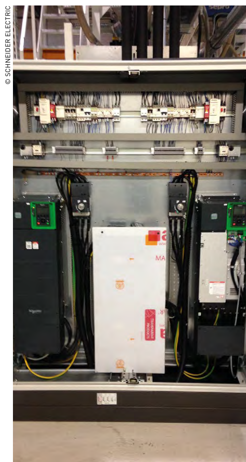
Schneider Electric propose du sur-mesure, en ajoutant une armoire électrique en bout de ligne dans laquelle sont installés des variateurs de vitesse de la gamme ATV600.
