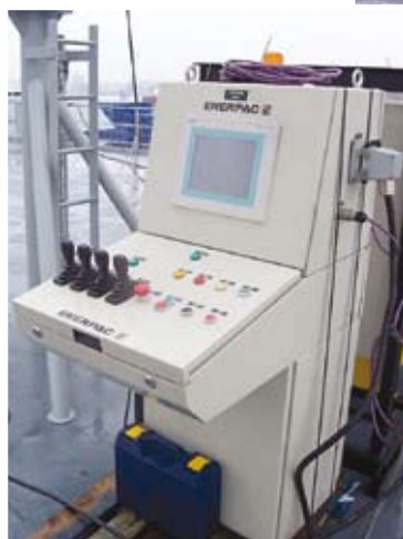
Pendant le levage et le positionnement, l'ensemble des forces est parfaitement contrôlé à l'aide de capteurs et d'un système CLP. Les conditions atmosphériques jouent un rôle moins important que dans une application à deux grues.
