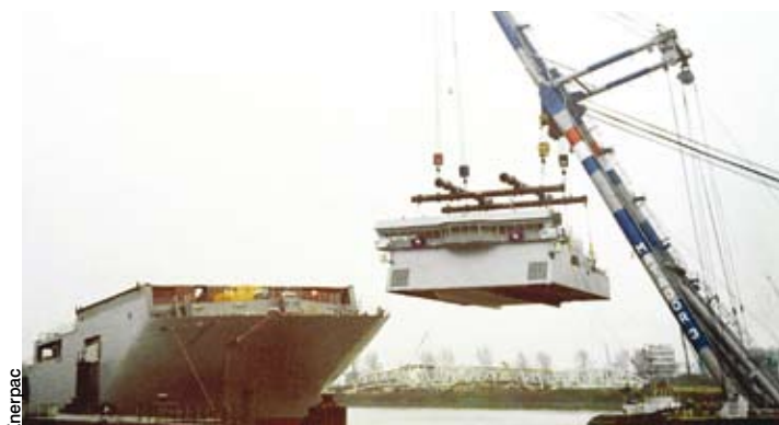
Avec le système hydraulique SyncHoist d'Enerpac il a suffi d'une seule grue flottante pour installer la superstructure.
